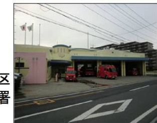
▲桜消防署：庁舎
