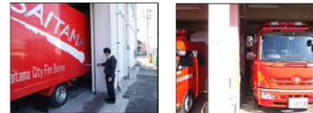
▲敷地狭隘のため、消防車両と壁・柱の間隔が狭い状況
